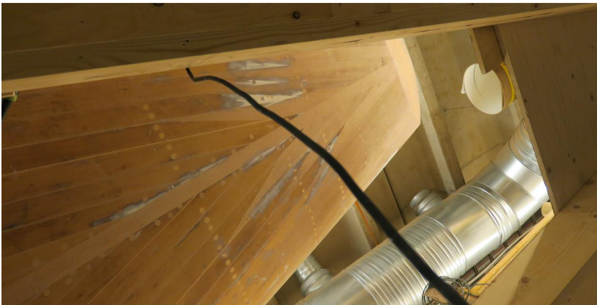
På bilden ses tydligt hur de nya borden laskats in för att få tillbaks ursprunglig längd (de ljusare borden)
