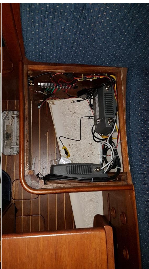
Låda vid mast efter byte.
